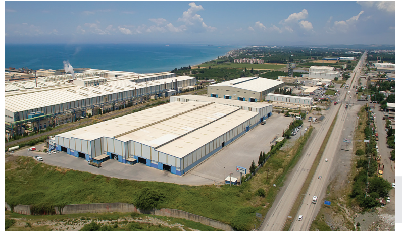
Çayirova Pipe Plant Dörtöy/Hatay
